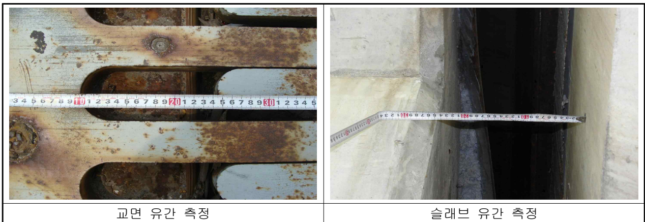
【사진 3.8】 유간 측정 현황
